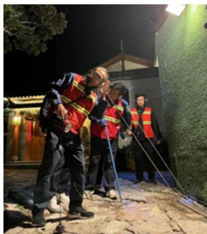
到漏水的声音并不稀奇，能准确判定漏水点的具体位置才是真本领。通过探漏仪确定大概位置后，就会用听漏杆进一步精准定位。老道的经验与先进的技术结合，造就了现在丽江水务集团探漏队专业高效的口碑。
